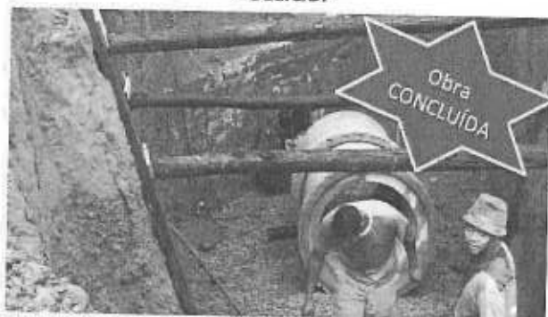
Recuperação de rede de drenagem pluvial Lúcio Costa - Guarã/DF
