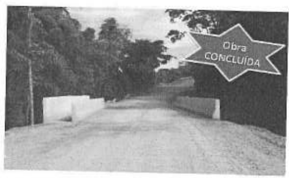
Ponte no Gama
