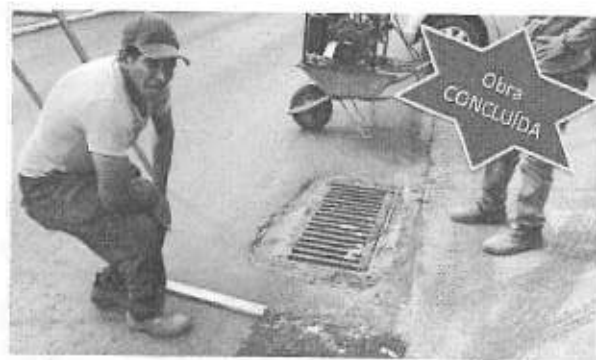
Execução de drenagem pluvial em diversas quadras do Gama
