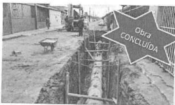
Execução de drenagem pluvial na QNP 28 conjunto "Q" - Ceilândia
