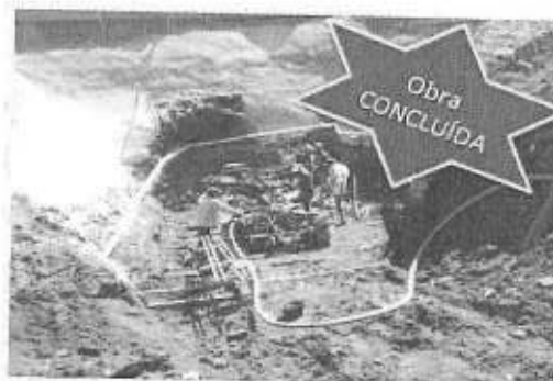
Execução de Túnel NATM e grampeamento dos taludes Avenida Elmo Serejo - Taguatinga/DF
