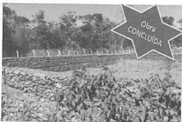
Execução de pavimentação e drenagem das vias internas do Aterro Sanitário
