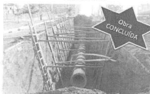
Execução de drenagem pluvial Centro Urbano de Samambai Quadra 101/109
