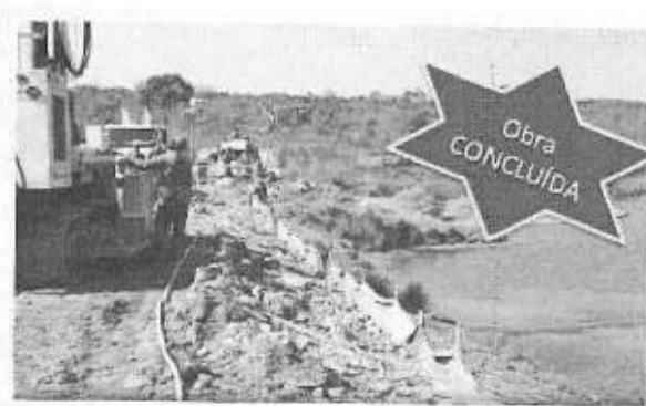
Barragem de Vargem Bonita
