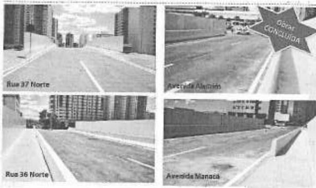
Construção de 04 Viadutos em Águas Claras
