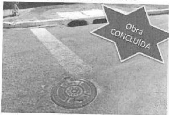
Remanejamento de drenagem pluvial na Quadra 16 lote 145 - Setor Leste do Gama
